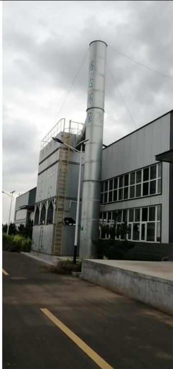
木工车间（木门）中央除尘系统及 15 米高排气筒（P3）
