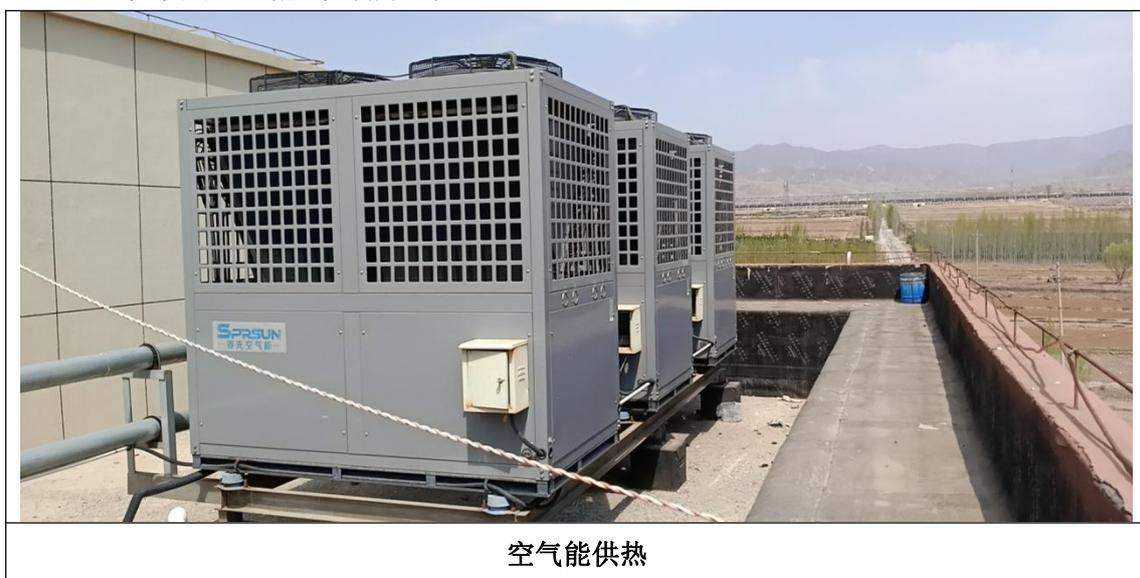
图 3.2-2 空气能供热装置现场照片
