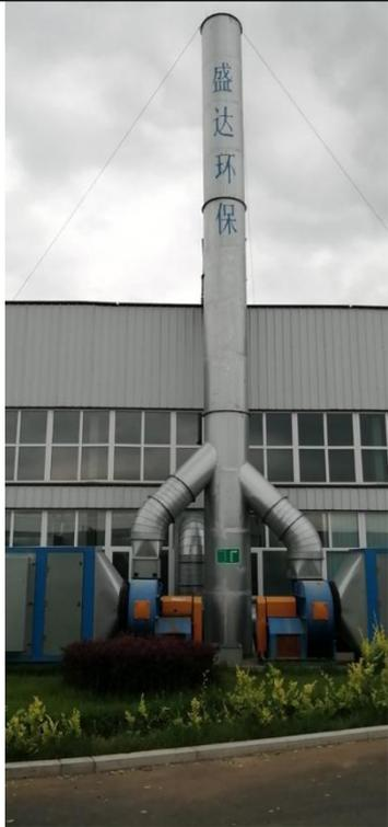
涂装车间（底漆）UV 光氧废气净化设备+活性炭吸附装置及 15 米高排气筒（P5）
