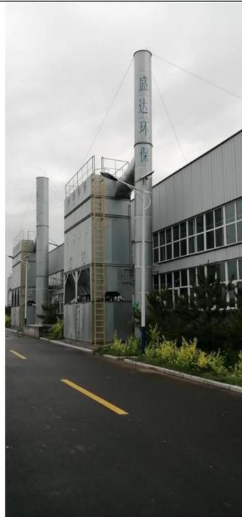
木工车间 (橱柜) 中央除尘系统及 15 米高排气筒 (P2)
