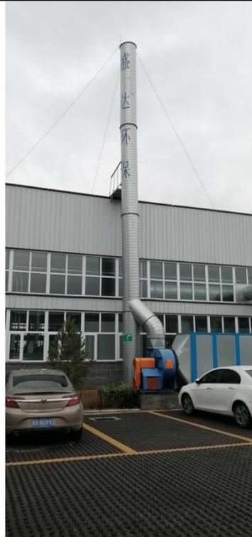
涂装车间（UV）废 UV 光氧废气净化设备+活性炭吸附装置及 15 米高排气筒（P6）
