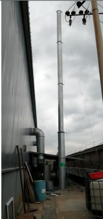
金属喷粉烘干废气 15 米高排气筒 (P1)
