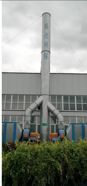
涂装车间（面漆）UV 光氧废气净化设备+活性炭吸附装置及 15 米高排气筒（P4）
