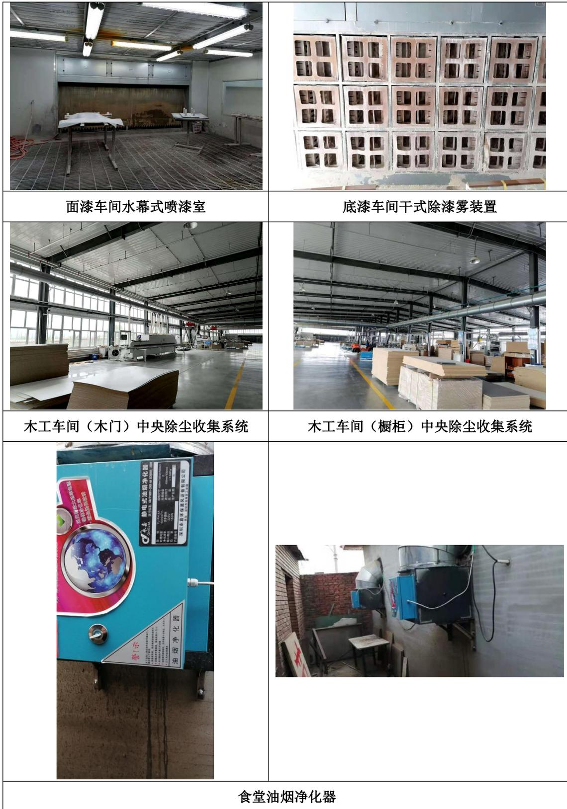
图 3.2-3 废气处理装置现场照片
