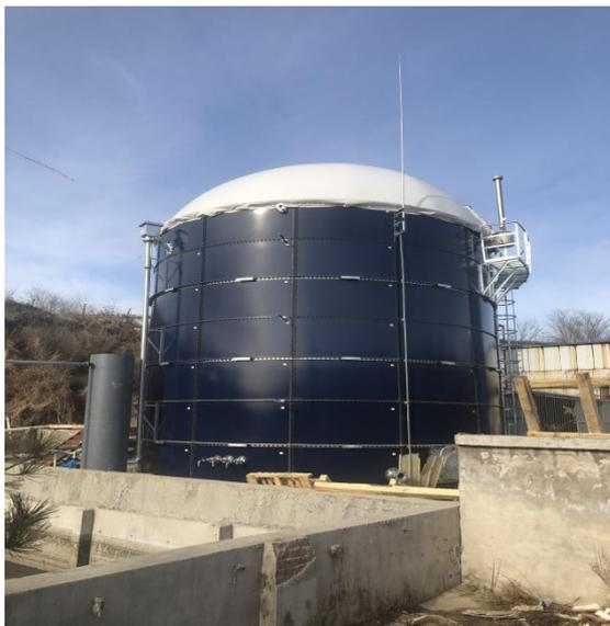
图 3-1 UASB 厌氧发酵罐
